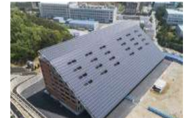
중앙연구소 종합연구동 (1.1MW)
