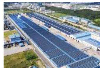
대죽공장 석고보드 3호기 (5.6MW)
