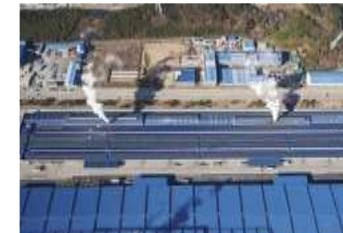
대죽공장 석고보드 1,2호기(2.0MW)
